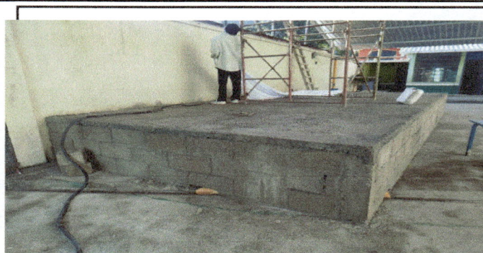
Foto 2: MODULO 2 Se sustituir el esenario en mas estado de madera, por un de concreto con piso ceramico
