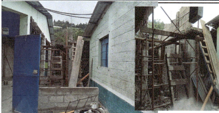
Foto 1: MODULO 1: Continuidad de paredes, cubierta de lamina y colocacion de canales pluviales de aula de preprimaria, para tener un mejor espacio
