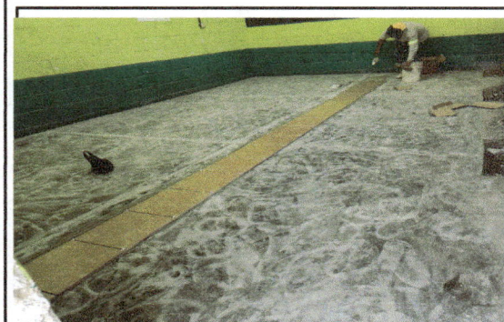
Foto 3: MODULO 3; Colocacion de piso ceramico en la direccion.
